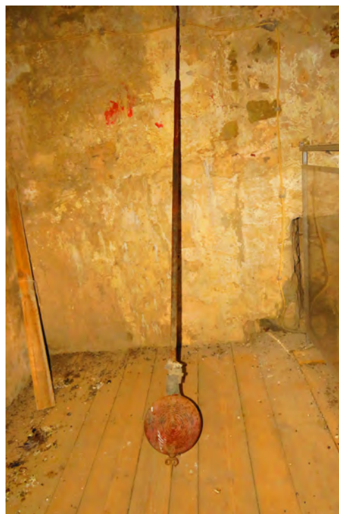
Campanile del Duomo di San Servolo a Buie
